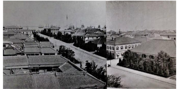
「日本大通り」 横浜開港資料館
